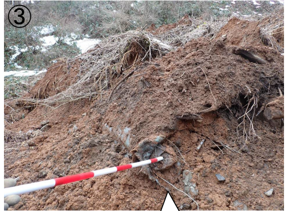
崩土に埋没したふとんかご(著しく変形していた)
