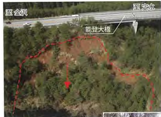
上り側橋台側面の崩落 (H19.3月)
