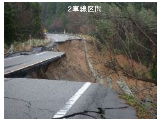
4車線／2車線区間の崩壊事例
