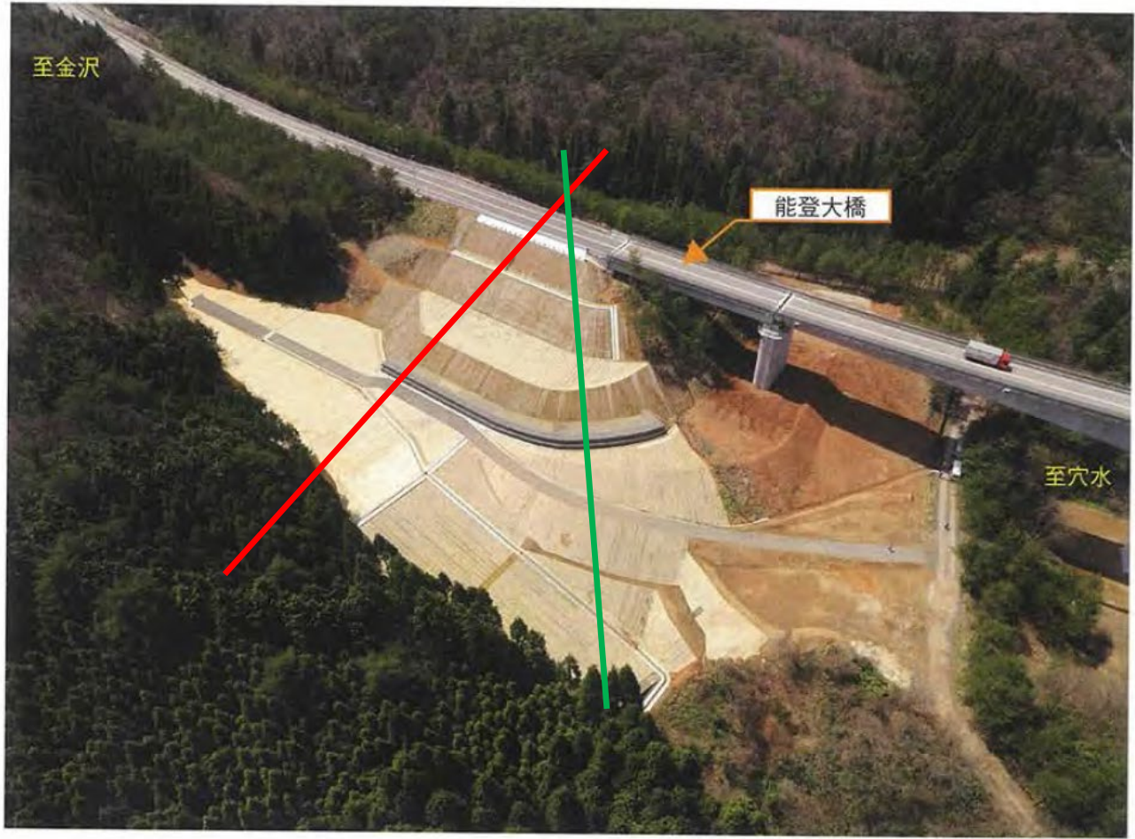
④ 本復旧工事完了 (平成20年 3 月31日撮影)
