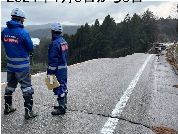
七尾市中島町谷内における盛土変状調査状況
