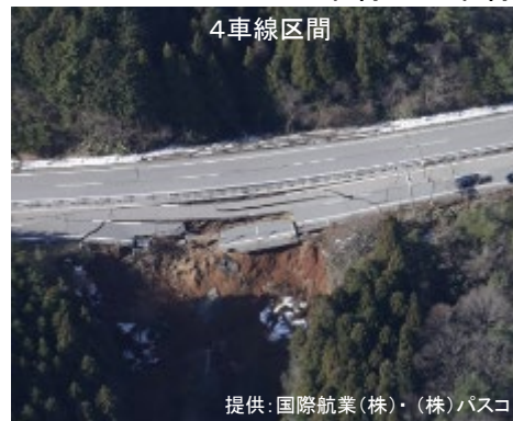
4車線／2車線区間の崩壊事例
