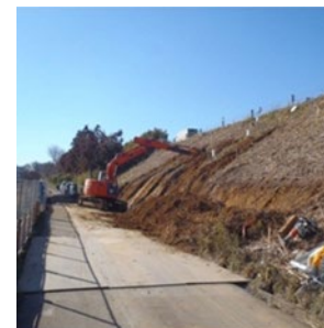
バックホウで掘削
