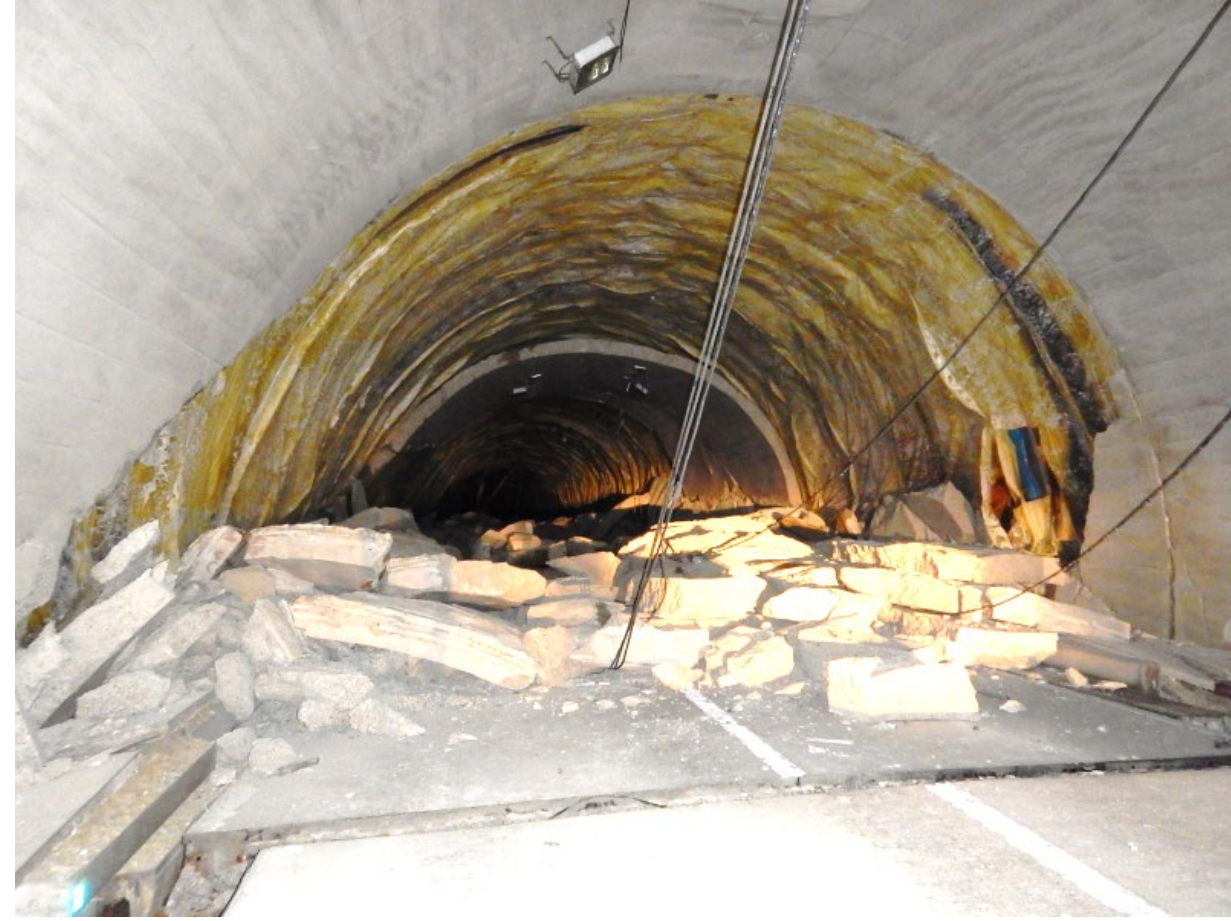
大谷Tnの様子（坑口から50m）
