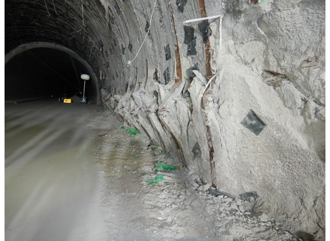
支保工の状況（防水シート撤去後）
