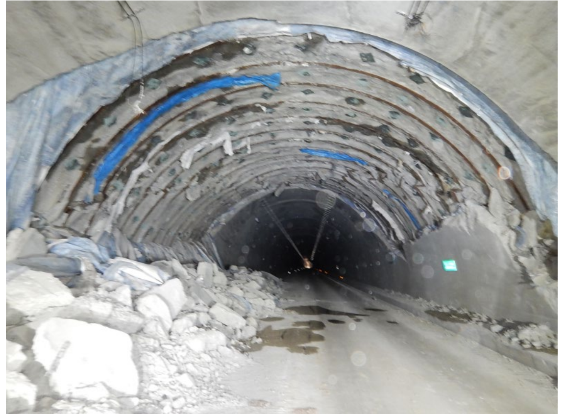
支保工の状況（防水シート撤去後）
