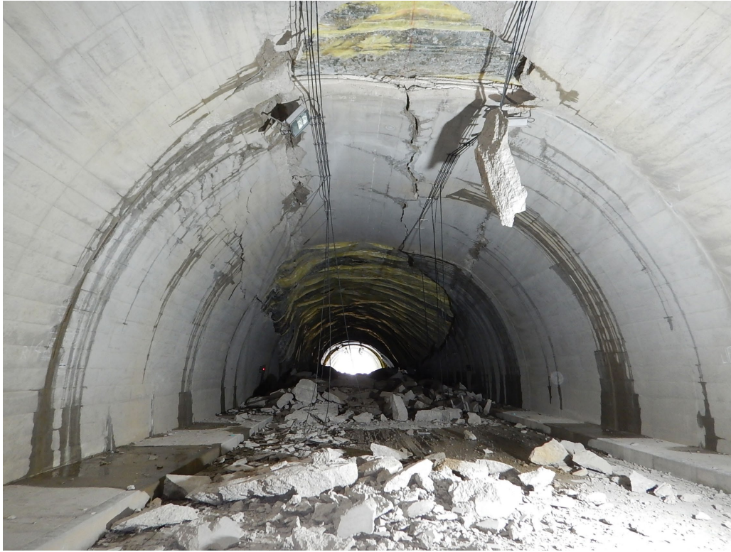
スパン13付近を北から南向きに撮影
