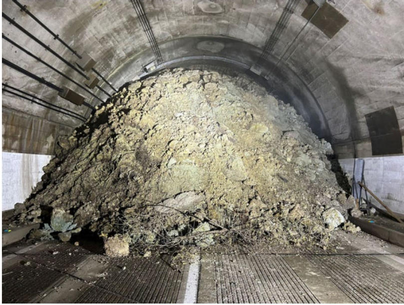
逢坂トンネル
