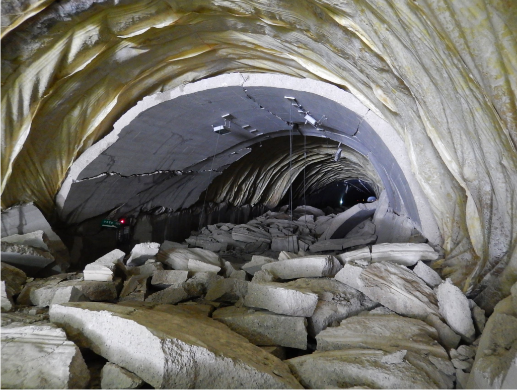
スパン7付近を南から北向きに撮影
