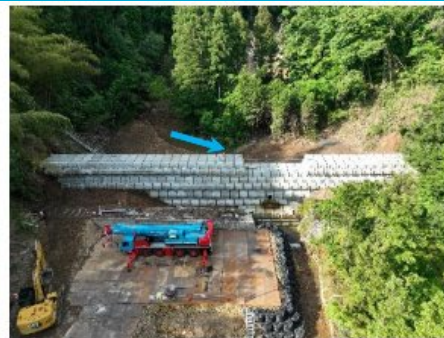
応急対策工事状況(寺地川) ブロック堰堤設置完了
