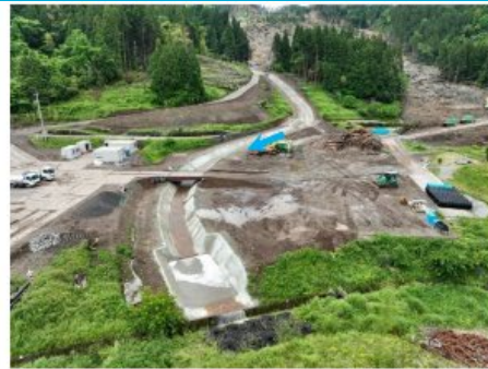
応急対策工事状況(紅葉川) 仮排水路設置完了
