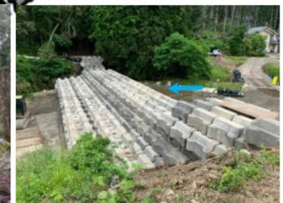
応急対策工事状況(鈴屋川(牛尾川)) ブロック堰堤設置完了
