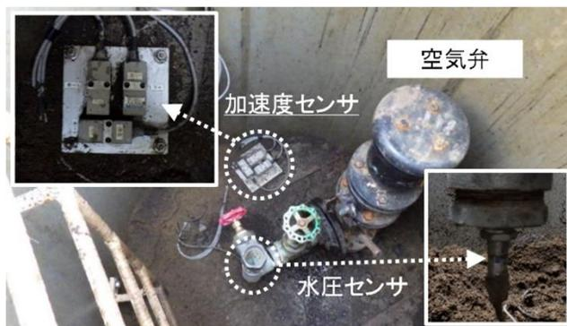
空気弁内における水圧計および加速度計の設置状況
