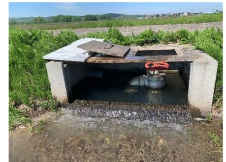
パイプラインから圃場への農業用水の供給の様子(給水口)
