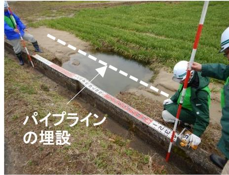
埋め戻し材料の液状化の噴砂
