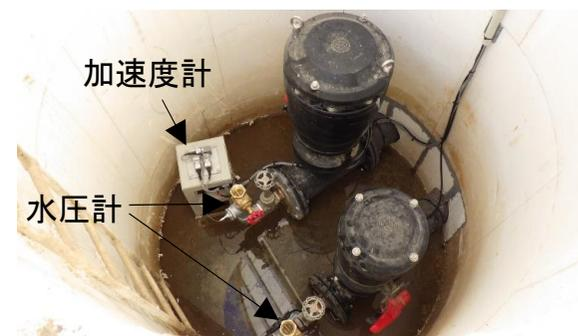
空気弁施設内の観測設備設置状況
