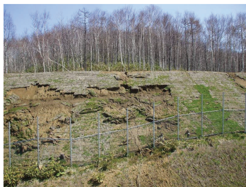
写真 切土のり面の崩壊事例
