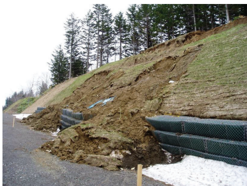
写真 切土のり面の崩壊事例
