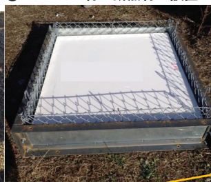
② ドレイン材と断熱材の設置
