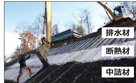
写真 断熱特殊ふとんかご施工の様子
