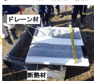
② ドレイン材と断熱材の設置
