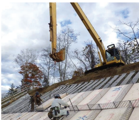
写真 断熱特殊ふとんかご工施工の様子
