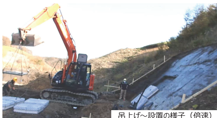
吊上げ～設置の様子（倍速）
