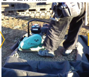
⑤ 中詰材の転圧
