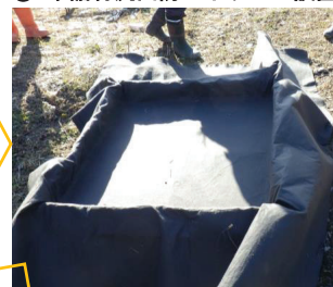
③ 中詰材流出防止ネットの設置
