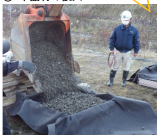
④ 中詰材の投入
