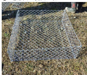
① 籠底面と側面の組立
