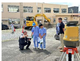
⑤杭ナビ・GNSS測量体験
