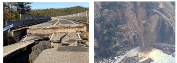
被害状況(左:のと里山海道/右:国道249号法面崩落)
