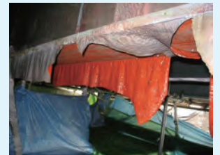
塗膜の除去状況
