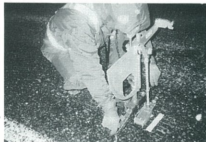
写真2 現地連続計測状況
