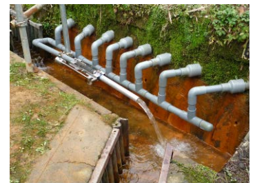
写真-5 集水管閉塞防止器
