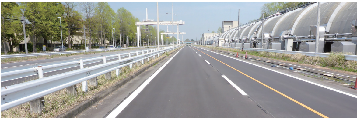
写真- 7.1.3 低燃費舗装の試験施工
