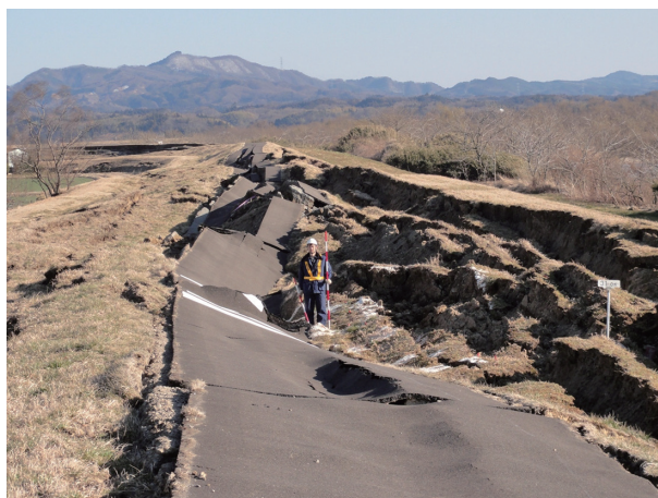
写真－2.2.1 堤体液状化による代表的な被災事例
