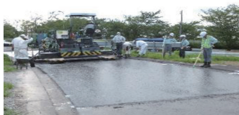
写真－ 3.1.6 防水性能に優れたグースアスファルト混合物の開発
