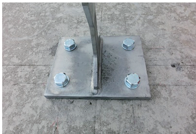
写真－4.5.2 あと施工アンカーによる支柱の固定
