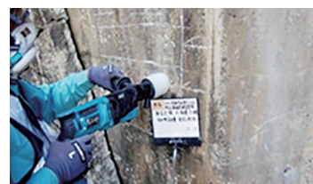
写真-3.2.2 ドリル法による塩分量調査
