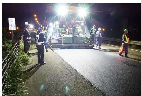
図－4.1.12 低燃費舗装の活用事例
