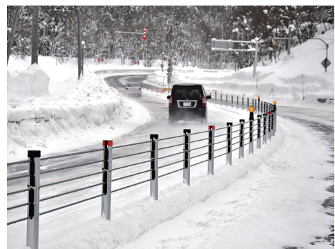
写真－ 9.2.1 ワイヤロープ式防護柵
