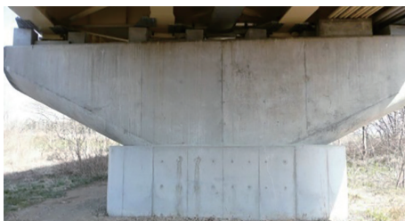
(a) 耐震補強が実施されていた橋
