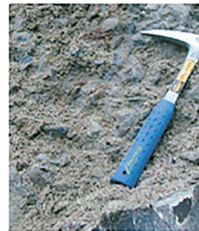
(b) 凍害による再劣化
