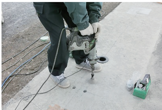
写真－4.5.2 あと施工アンカーによる支柱の固定
