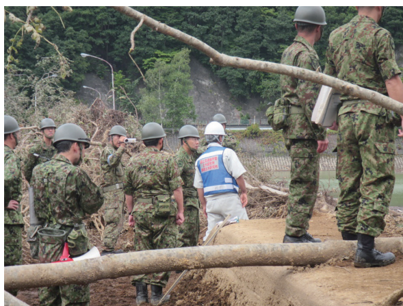
写真－ 5.1.2 厚真ダム復旧に向けた技術指導
