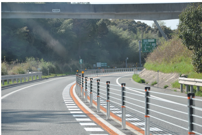
写真－4.5.1 ワイヤロープ式防護柵
