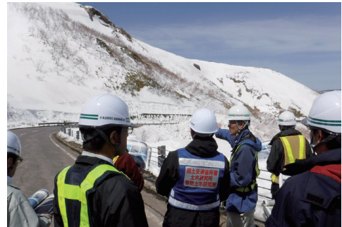
写真－2.4.7 国道 334 号知床横断道路における技術指導の状況
