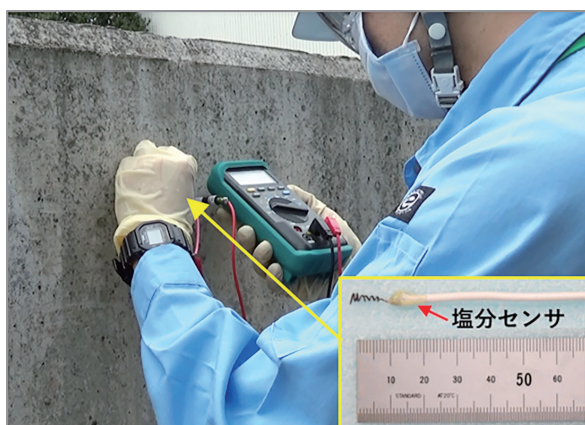
写真－7.1.1 小型の塩分センサを用いた コンクリート構造物の塩害調査
