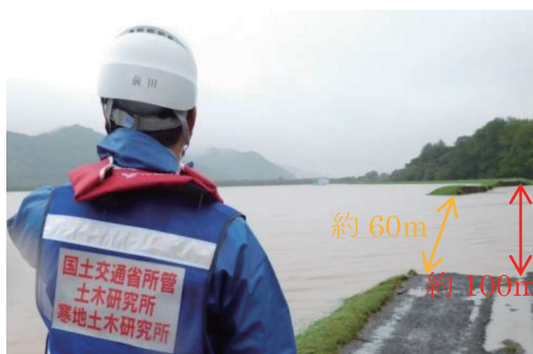
写真－ 5.1.3 河川堤防決壊の現地調査状況
