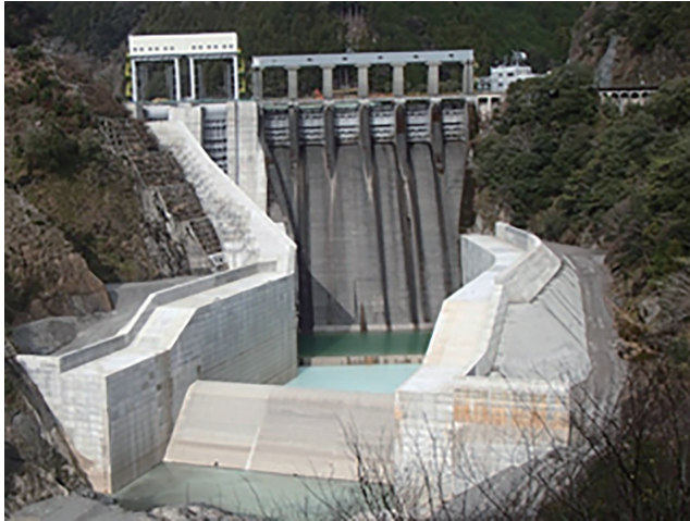
写真－2.2.2 長安口ダム改造事業（堤体開削による洪水吐き2門等の増設）（左）と大型水理模型実験（右）
