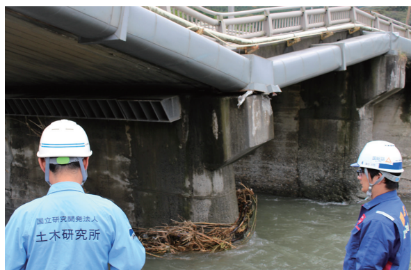
写真－ 5.1.6 被災橋梁の調査の様子
