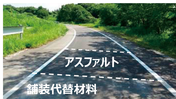
舗装走行実験場での耐久性評価
