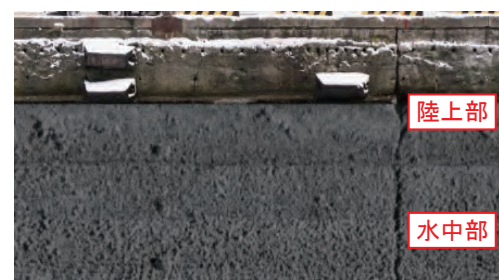
図-2.2.1.6 水中部のモザイク図と陸上部の一体画像
