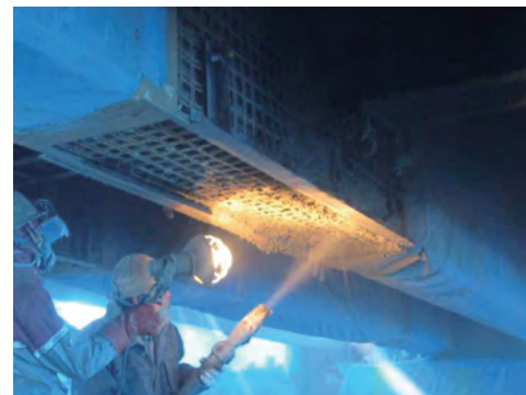
写真-2.2.3.7 補修・補強技術の施工例
