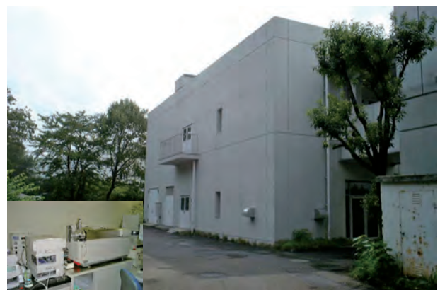
写真- 2.1.4.1 微量物質分析棟
