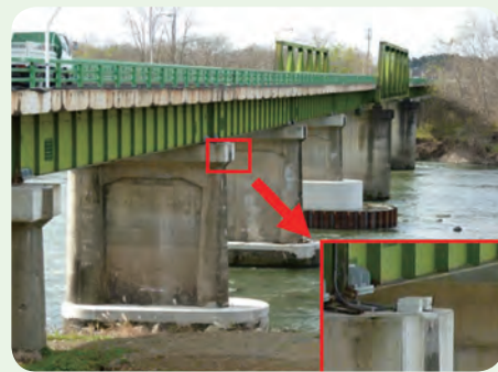
橋梁地震被災度判定システムの適用状況
