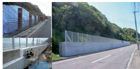
写真-2.2.2.7 杭付落石防護擁壁
