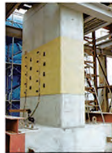
写真-2.2.2.8 アラミド繊維シート補強
