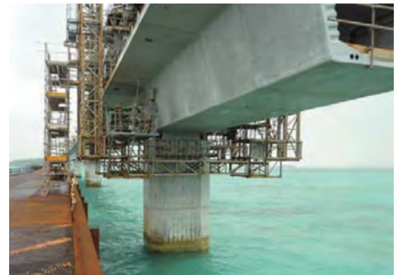
(c) 海洋部の橋脚コンクリートの経年調査 (管理者と連携し、コア抜き調査を継続的に実施する。)
