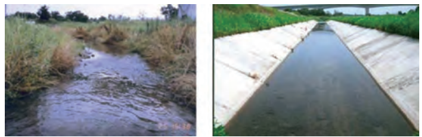
写真- 2.1.4.9 植物繁茂を制御した実験
