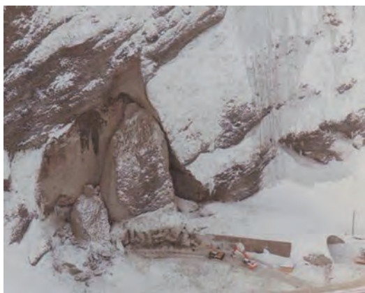
写真- 2.2.2.18 豊浜トンネル崩落事故
