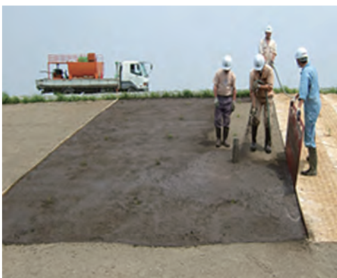
写真- 2.2.4.10 主力種（ヨシ苗植生） + 混播種（種子吹付）
