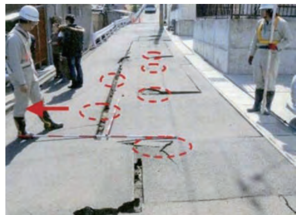
図-2.1.6.10 地すべり対策の地震による変形
