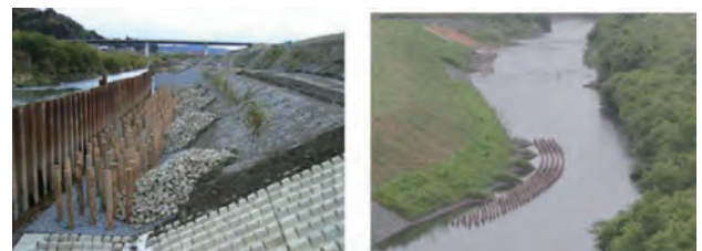
図-2.1.4.16 砂鉄川における水際部修復工法の導入
