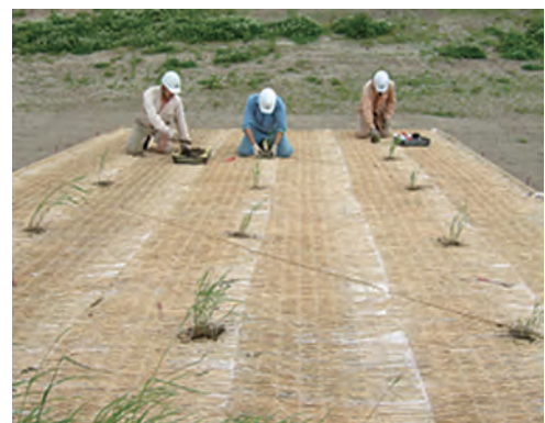
写真- 2.2.4.11 主力種（ヨシ苗植栽） + 混播種（植生シート）
