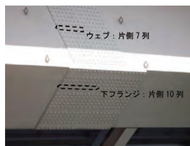
写真- 2.4.5.11 鋼桁への多列ボルトの適用例
