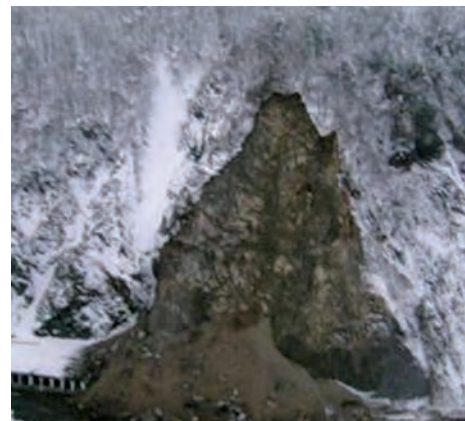
写真- 2.2.2.19 えりも斜面崩壊
