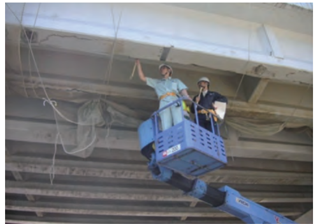
写真-2.4.2.1 劣化した道路橋の現地調査
