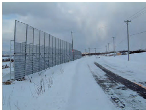
写真-2.2.5.11 高盛土対応型の高機能防雪柵
