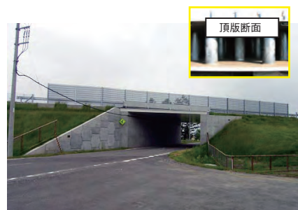
写真-2.2.2.14 複合構造横断函渠
