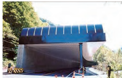
写真-2.2.2.6 サンドイッチ落石覆道
