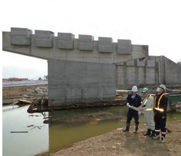
写真-2.4.2.4 東北地方太平洋沖地震での被災地での技術支援
