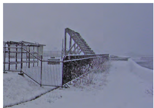
写真- 2.2.3.12 留萌暴露実験場
