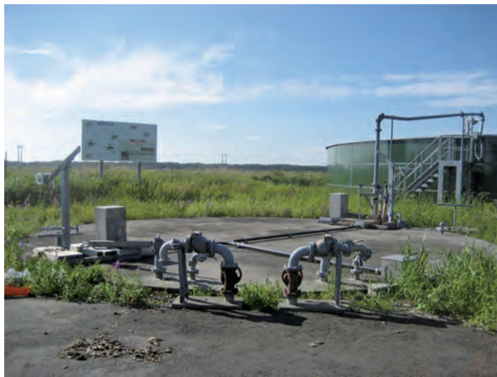
写真- 2.2.6.5 地下埋設型の曝気槽
