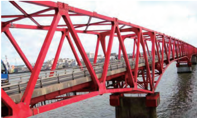
(a) 腐食劣化した鋼トラス橋の荷重試験 (腐食劣化により断面欠損が生じた鋼橋の活荷重に対する挙動を調査した。)
