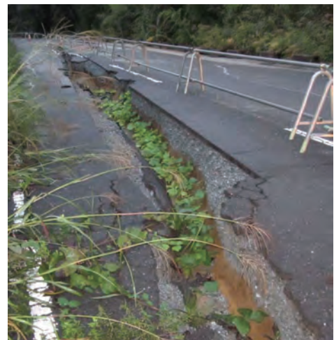
図-2.1.7.13 土工部の変形による亀裂
