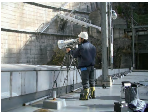
写真-2.1.5.4 赤外線カメラを用いたアーチダムの劣化調査
