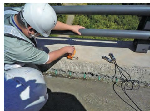
写真-2.2.3.8 超音波による凍害劣化診断
