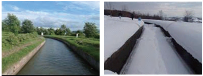
写真-2.2.6.6 コンクリート開水路が曝される環境（夏期・冬期）
