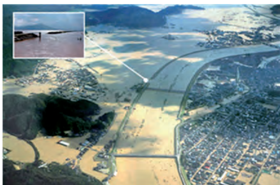
写真- 2.2.4.6 越水破堤災害（丸山川）
