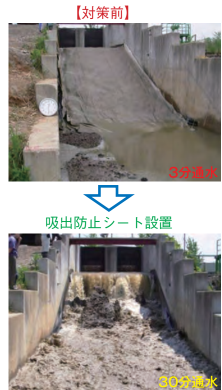
写真-2.1.5.8 「シート工法」による耐侵食性向上効果例
