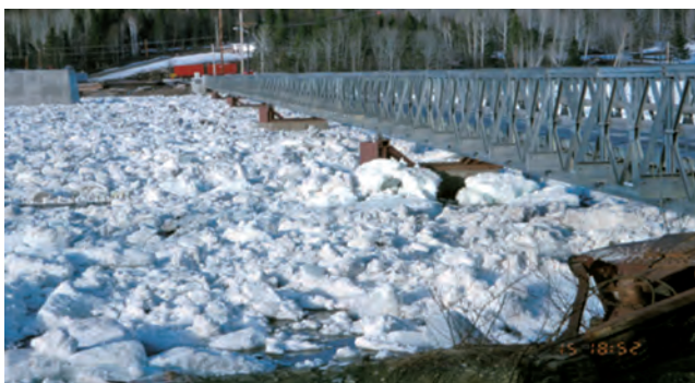
写真- 2.2.4.4 橋脚周辺のアイスジャム
