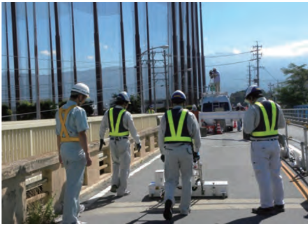
(a) 撤去前の実橋での非破壊調査 (道路橋の撤去に際して、非破壊検査機器開発者が、それぞれの機器で床版の劣化状況を調査した。)
