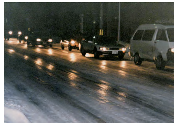
写真-2.2.5.3 つるつる路面の状況
