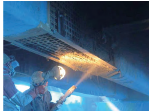
写真-2.2.3.7 補修・補強技術の施工例
