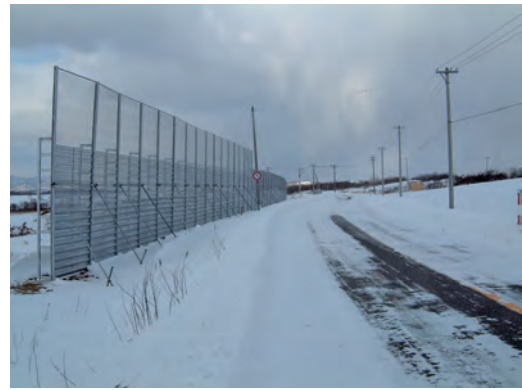
写真-2.2.5.11 高盛土対応型の高機能防雪柵
