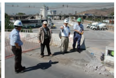
写真-2.4.4.5 チリ地震後の現地調査
