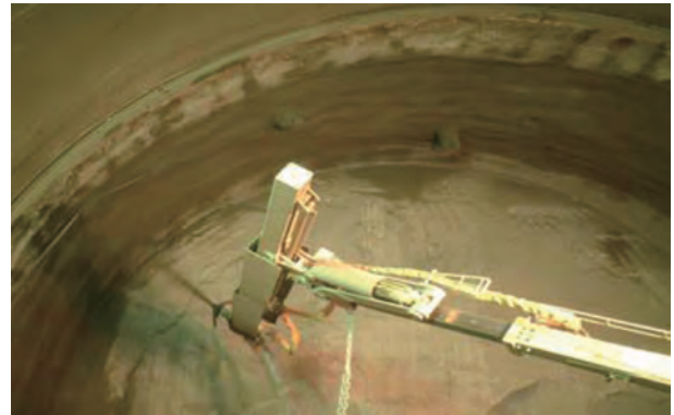
写真-2.1.3.6 液体急結材による方法
