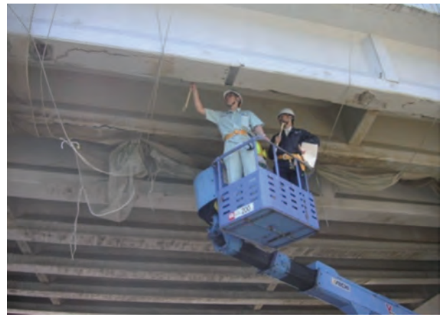
写真-2.4.2.1 劣化した道路橋の現地調査
