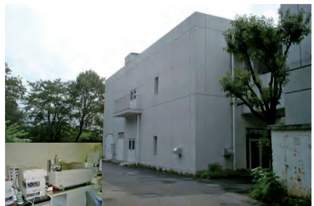
写真- 2.1.4.1 微量物質分析棟
