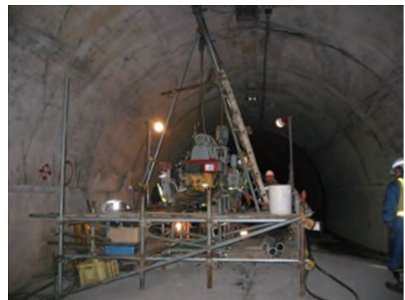
写真-2.1.7.3 変状が発生したトンネルにおける計測の状況
