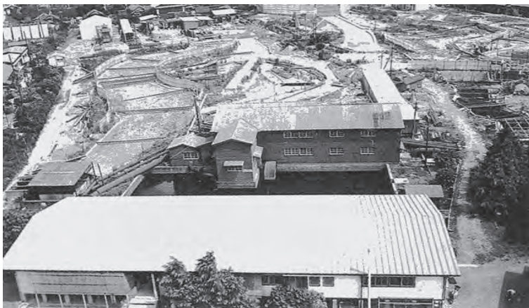
写真－1.2.1 篠崎試験所
