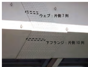
写真- 2.4.5.11 鋼桁への多列ボルトの適用例
