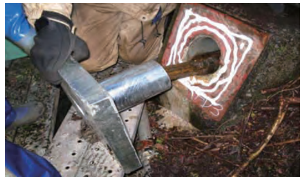
写真-2.1.3.9 背面保護管付き支圧板を利用した補修補強した事例
