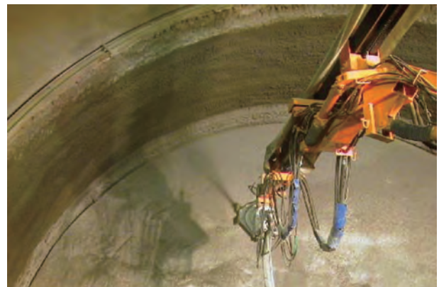
写真-2.1.3.7 遠心力タイプの吹付け機械による方法
