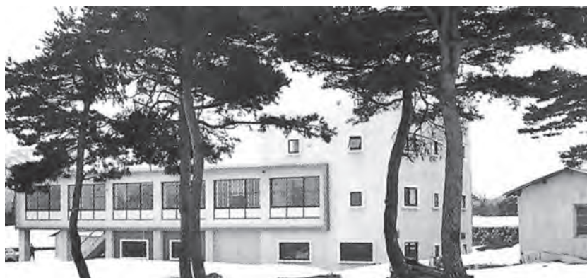
写真－ 1.2.3 新潟試験所
