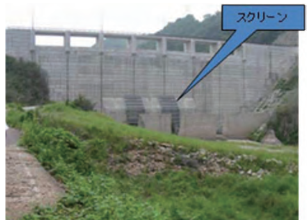
写真-2.1.5.6 益田川ダム(上流面)
