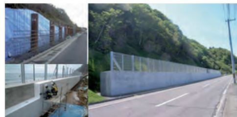
写真-2.2.2.7 杭付落石防護擁壁
