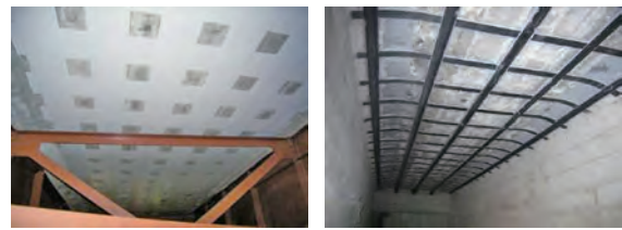
写真-2.2.2.12 炭素繊維を用いた床版下面補強例
