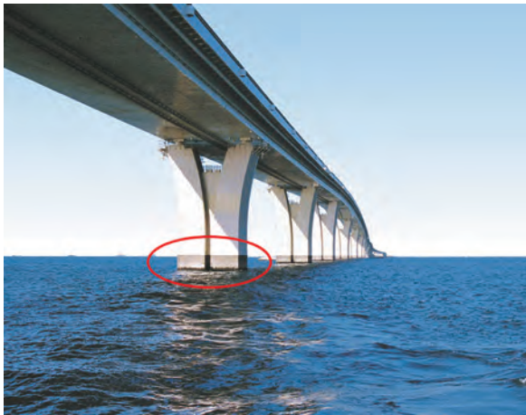
写真-3.1.5 東京湾横断道路におけるチタンクラッド鋼による防食の採用（赤線囲み部分）
