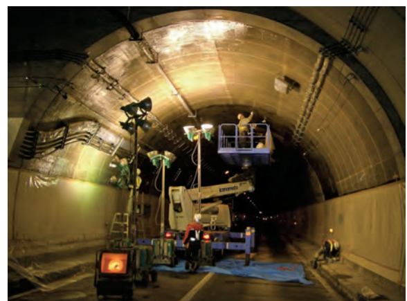
写真-3.2.5 トンネル補修工の施工
