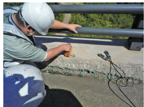
写真-2.2.3.8 超音波による凍害劣化診断
