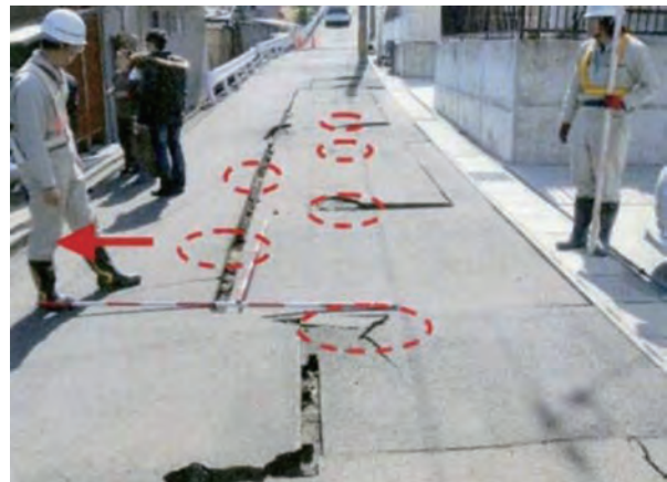
図-2.1.6.10 地すべり対策の地震による変形
