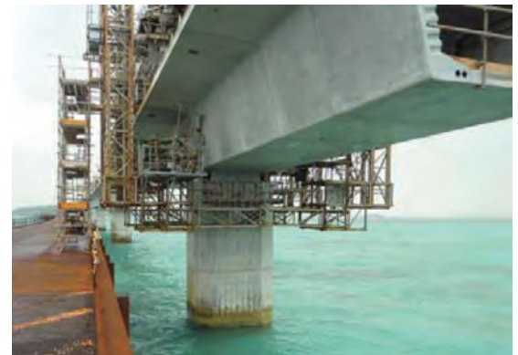
(c) 海洋部の橋脚コンクリートの経年調査 (管理者と連携し、コア抜き調査を継続的に実施する。)
