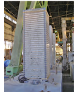
写真-2.2.2.9 アラミド繊維ロープ補強
