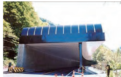
写真-2.2.2.6 サンドイッチ落石覆道
