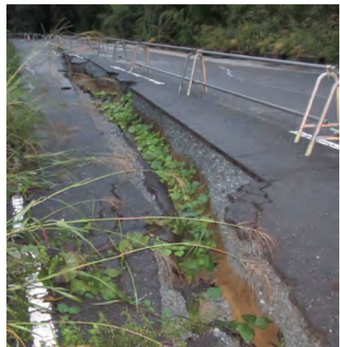
図-2.1.7.13 土工部の変形による亀裂
