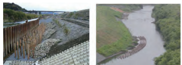
図-2.1.4.16 砂鉄川における水際部修復工法の導入
