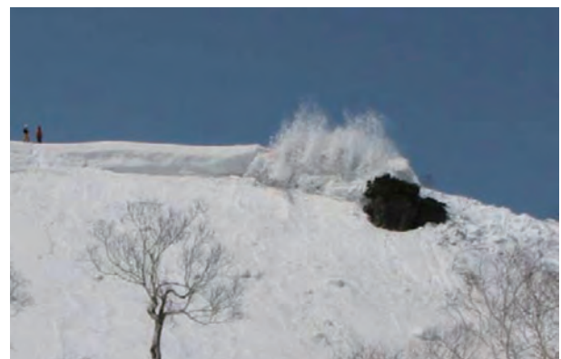
図- 2.1.6.19 掲載した雪崩処理の事例 (蒸気圧破碎薬剤を用いた雪庇処理事例)
