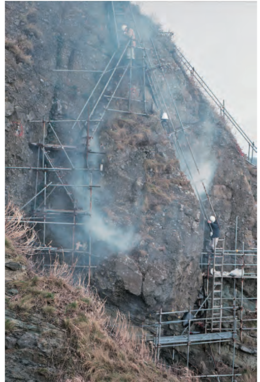
写真-1.2.3 エアトレーサー試験例
