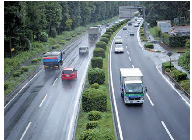
写真-1.3.4 密粒度舗装（左側）と排水性舗装（右側）
