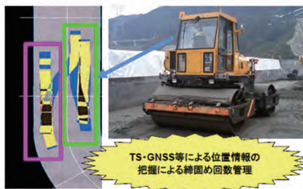
写真-3.3.3 締固め回数管理
