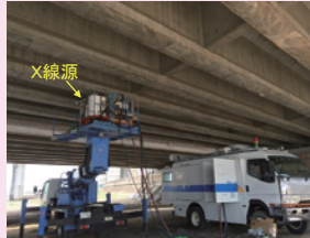
X線を用いてコンクリート橋内部のPC鋼線等の状態を把握し、補修の必要性の判断に活用する(CAESAR・東大)
