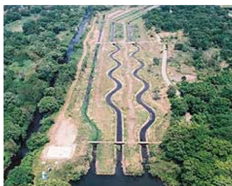
④自然共生研究センター 実河川から水を引き、 様々なしかけがある3本の実験水路
