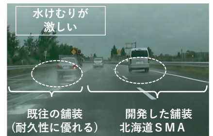
開発した舗装の施工箇所状況
