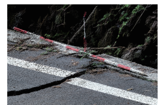
「虫の目」による詳細分析 各部分の詳細な状況がよく分かり、現地調査では危険なために近づけない場所も確認が可能
