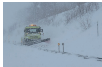
大雪による交通障害を防止するための除雪作業
