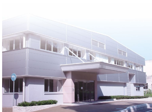
⑤水災害・リスクマネジメント国際センター 日本政府とユネスコの協定に基づき設置。 土木研究所・本館に隣接。
