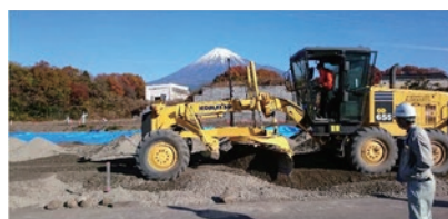
ICT 土木施工
