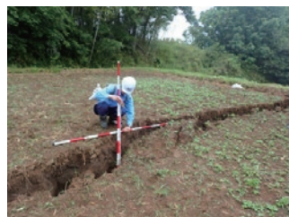
平成 29 年大分県豊後大野市綿田地区における地すべり調査
