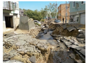
液状化による住宅地の被害
