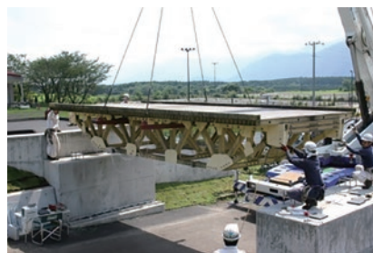
先端的構造材料の実大模型実験 (構造用 FRP の実験)
