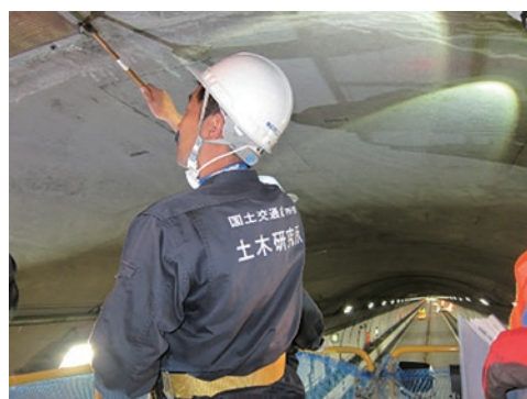
トンネル点検・診断の合理化に向けた取組みの例
