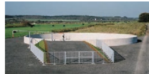
調整した乳牛ふん尿スラリーの 貯留施設
