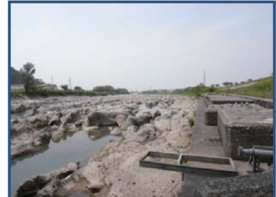
河床の低下・露岩化
