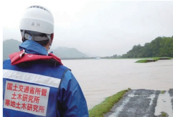
台風第 10 号等：北見市における堤防越水・堤防一部流出調査状況（平成 28 年 8 月 21 日撮影）
