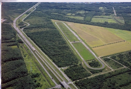
苫小牧寒地試験道路
