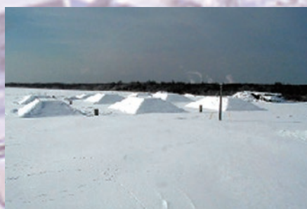
苫小牧施工試験フィールド
