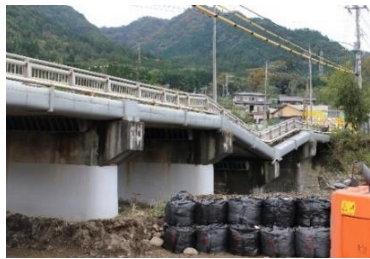
写真-3,4 国道 20 号法雲寺橋の被災状況(左)と道路管理者との打合せ(右)
