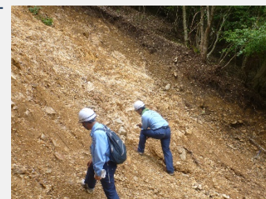
豪雨で崩壊した斜面の調査
