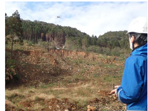
3次元モデルを作成するためにUAVで現場の状況を撮影します
