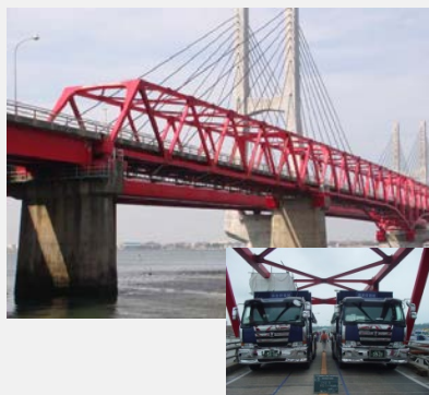
荷重車を用いた実橋の現地計測
