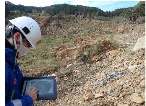
現場で3次元モデルを見ながら調査内容を確認します
