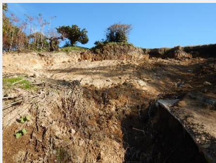
豪雨で発生した 地すべり災害の現場
