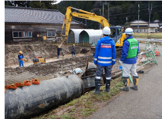
写真3 復旧工事の状況
