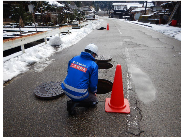
写真2 被災施設の調査
