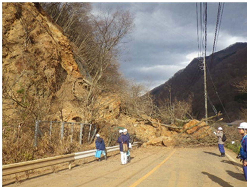
崩壊した土砂で通行できなくなった国道148号線
