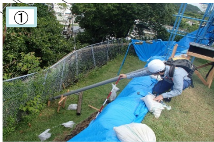
現地調査の様子① (ブロック頭部の状況)
