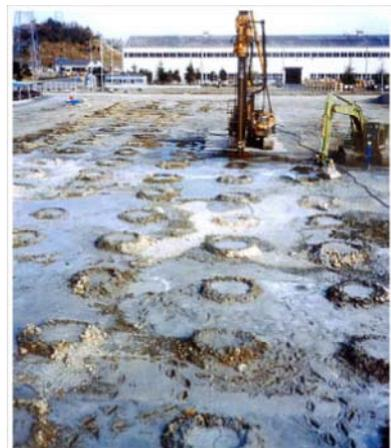
図-4 セメント改良柱体による軟弱地盤改良の実施例（タイ）<sup>3)</sup>
