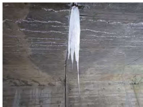
(d) 頂版継手部の氷柱
