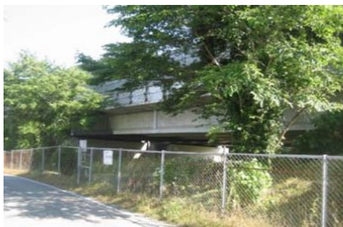
写真-1 全景写真 (A橋)
