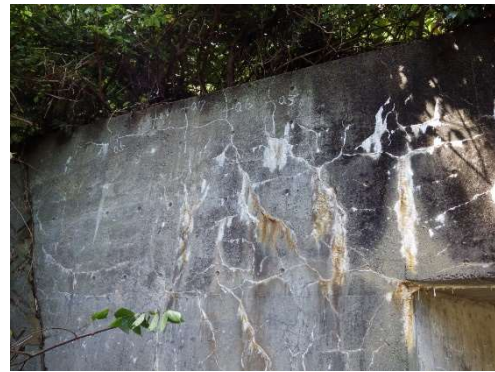
(a) アルカリ骨材反応によるひびわれ
