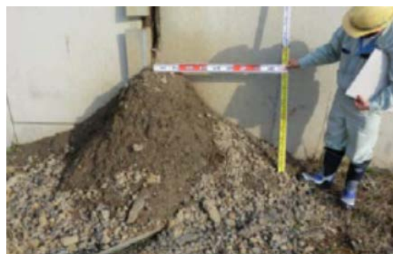
写真1 盛土材のこぼれ出し状況
