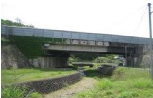
写真-3 全景写真 (C橋)
