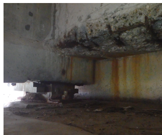
(a) 桁端横桁部
