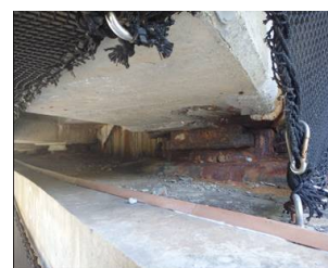
(b) 桁端部および支承
