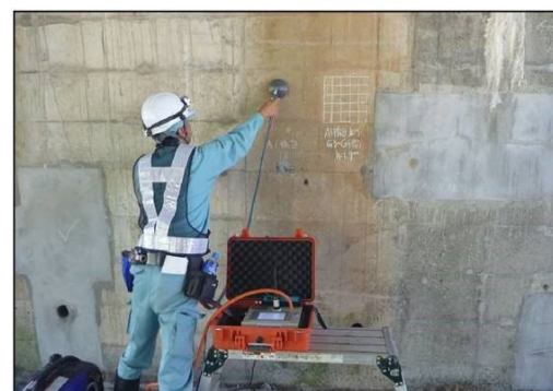
写真-12 測定状況 (表面透気試験)
