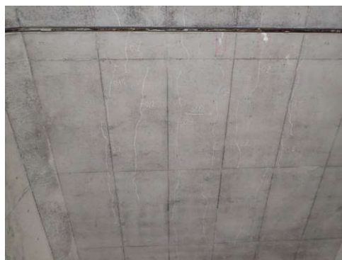
(a) 上載荷重によると考えられる軸方向ひびわれ (本写真は活荷重による例)
