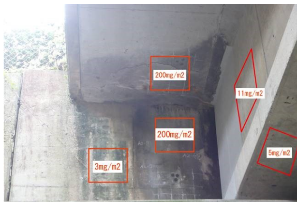
写真-13 付着塩分量分布 (A橋)
