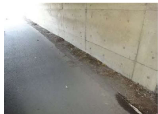
(b) 排水溝の土砂詰まり
