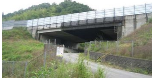
写真-2 全景写真 (B橋)
