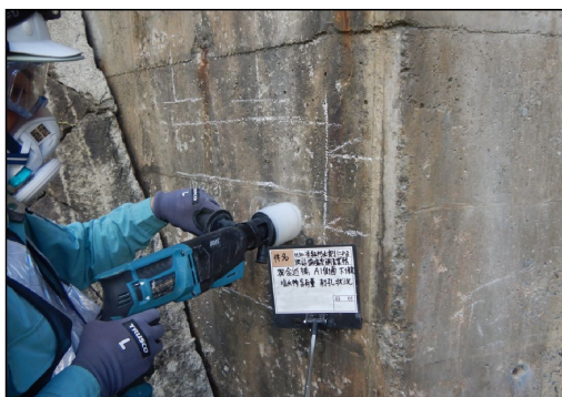
写真-11 測定状況 (ドリル法による測定)
