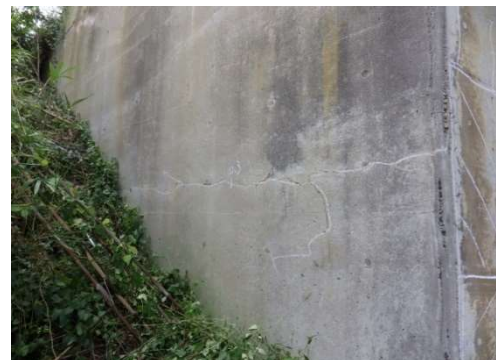
(b) 乾燥収縮によるひびわれ
