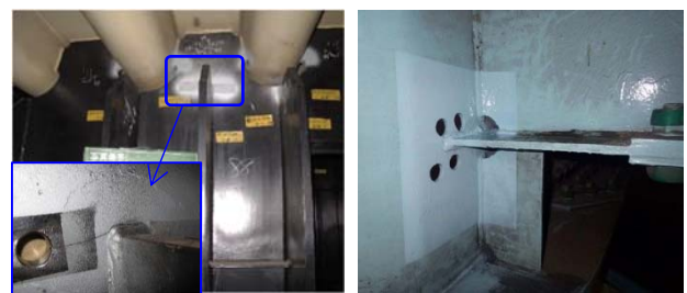
写真-6 ストップホールの施工事例
