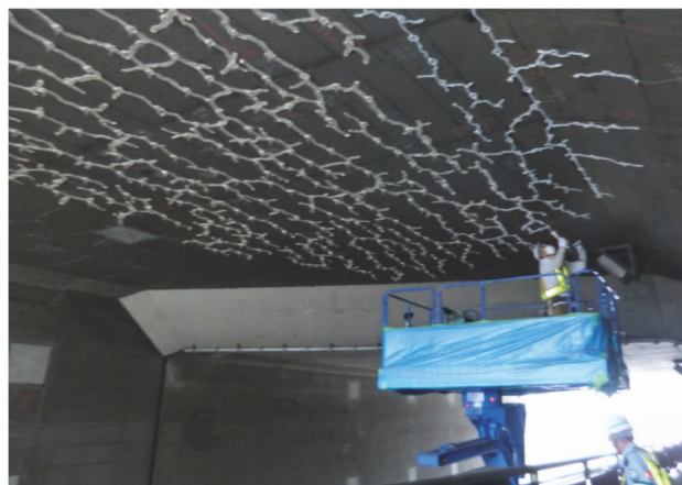
写真-2 ひびわれ補修の例
