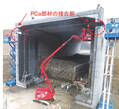
写真-1 機械式鉄筋継手を用いたプレキャスト部材例
