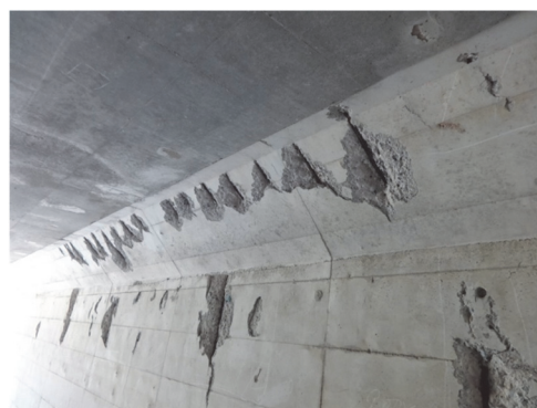
写真-6 うき・剥離のたたき落とし後の様子の例
