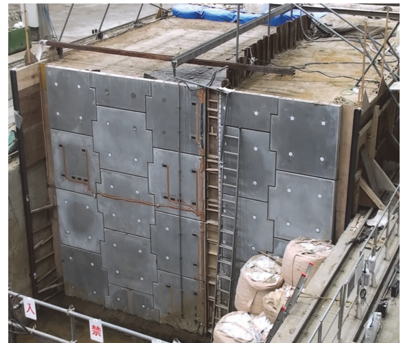
写真-1 補強土実大模型
