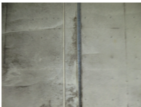
写真-8 開いた継手部の止水の例
