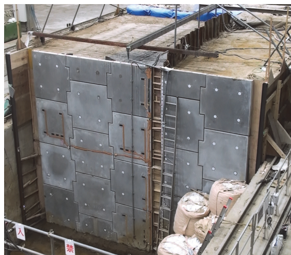
写真-1 補強土壁実大模型
