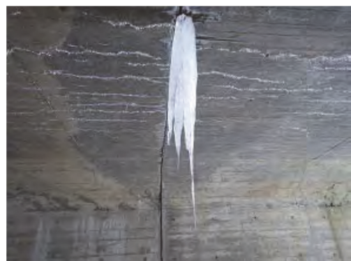
(d) 頂版継手部の氷柱
