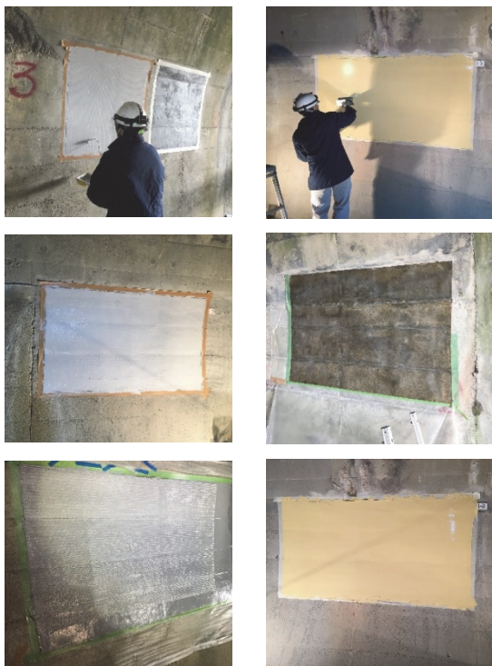
写真 3-3 はく落防止工の試験施工状況
