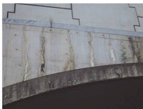
(b) ヒンジ式アーチカルバートウイングのひびわれの例
