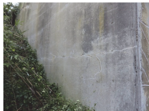
(b) 乾燥収縮によるひびわれ
