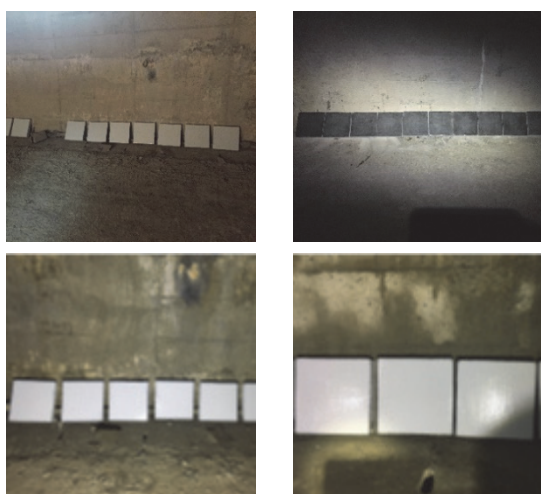
写真 3-4 はく落防止工を施工した供試体の暴露
