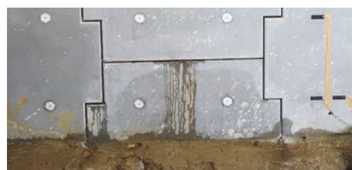
写真3 CASE1での目地部からの排水状況(最下段)
