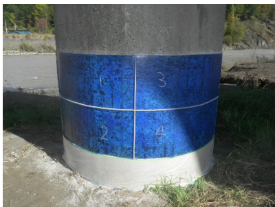
写真-9 エポキシ樹脂の再塗布
