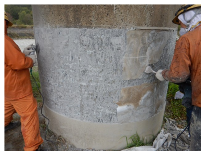
写真-6 保護モルタル1層目のはつり落とし
