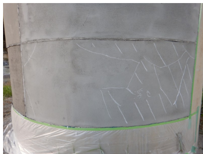
写真-10 プライマー無しの場合 (施工翌日)
