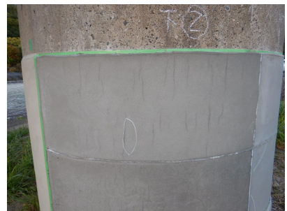
写真-11 プライマー+従来材料 (施工翌日)
