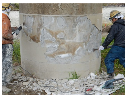
写真-4 浮き範囲のはつり落とし
