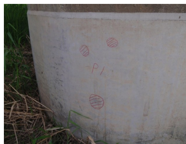
写真-2 円形の浮き (P1, 経年変化なし)
