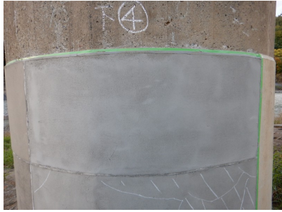
写真-12 プライマー+無収縮モルタル (施工翌日)
