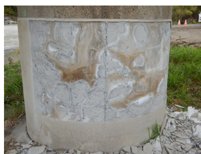
写真-5 浮き範囲外のはつり落とし
