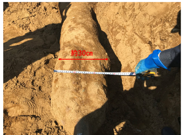
写真4.1.2 改良体造成状況 (材料④)
