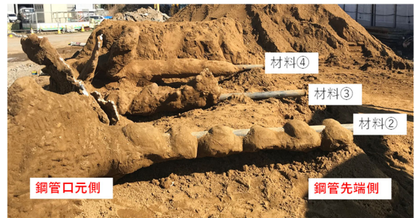
写真4.1.1 改良体造成状況 (材料②～④)
