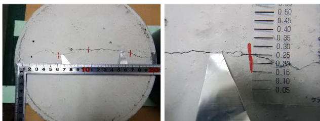
写真-3.3 暴露開始前のひび割れ幅測定状況
