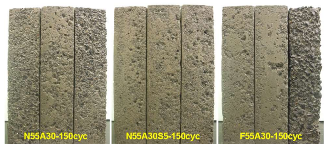
写真-3.6 凍結融解終了時の側面の状況 (ケース2)
