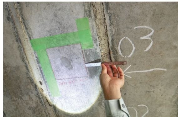
写真-13 表面含浸距離の測定状況（ケース3）
