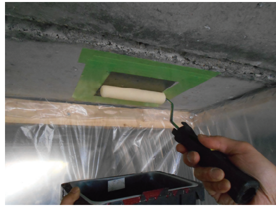
写真-12 塗布状況
