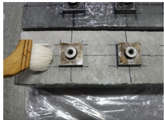
写真-9 塗布状況（刷毛）と無塗布範囲の覆い方
