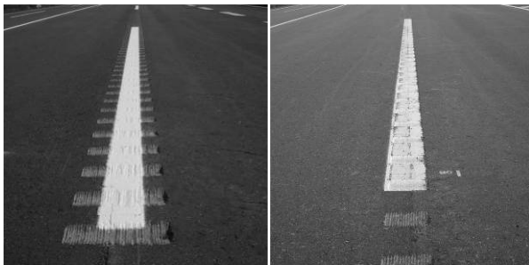
写真 3 白線波線区間のランブルストリップス （左：横幅 35cm、右：横幅 15cm）
