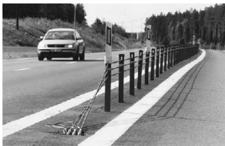
写真6 ワイヤーケーブル式の中央分離構造
