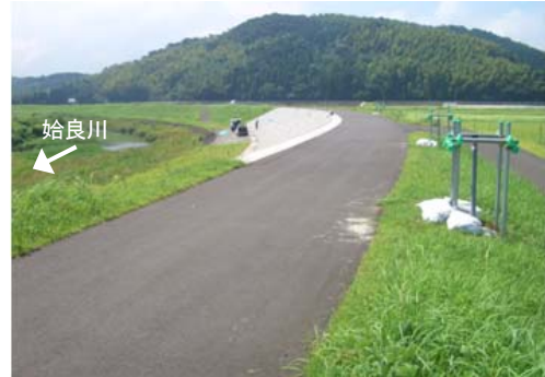
写真-2 観測孔の設置完了時の状況
