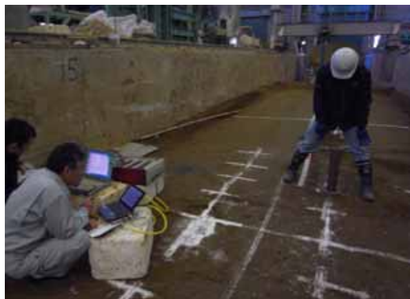
写真-4 重錘落下試験状況
