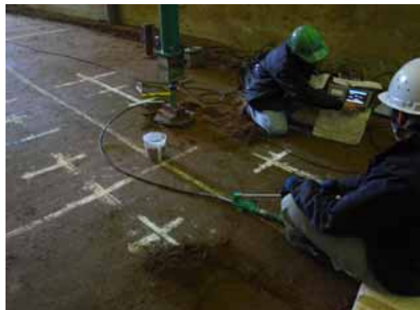
写真-4 平板載荷試験状況
