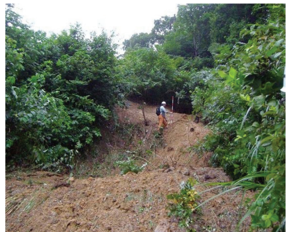
写真-1 切土のり面上方の小規模な谷地形(自然斜面)の崩壊事例(管轄事務所提供)
