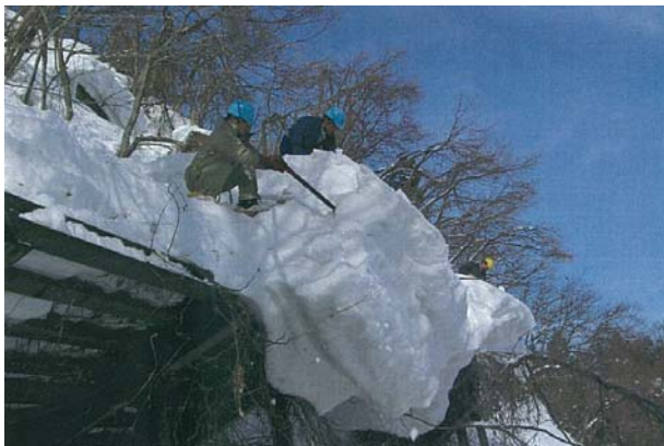
図 1 雪崩予防柵の上に発達した巻きだれの除去作業の様子（新潟県上越地域振興局提供）
