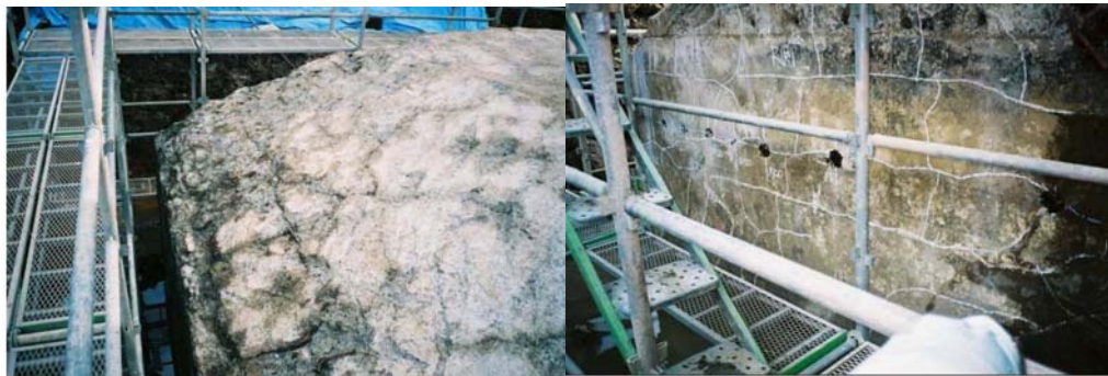
図4.2 A橋のフーチング上面のひび割れ状況
