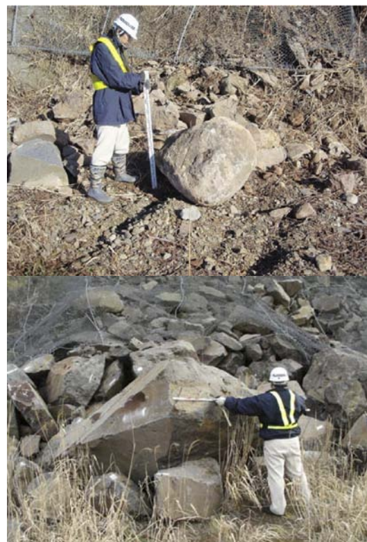
写真-IV 覆道上の落石状況
