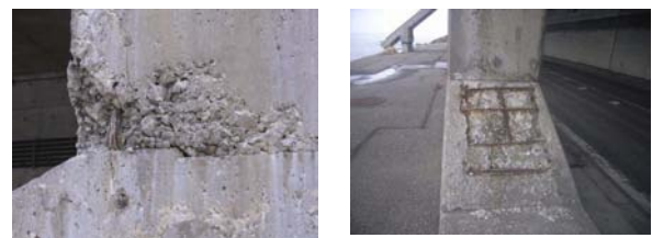
写真-II 覆道柱部の損傷状況(鉄筋露出)
