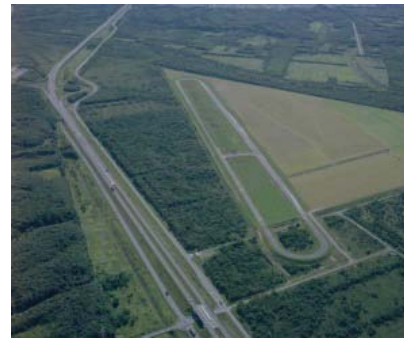
写真-9 苫小牧寒地試験道路
