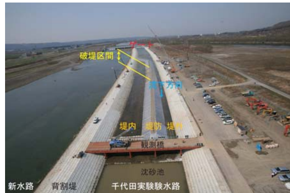
図-15 実験水路内に造成した水路内縦断堤防
