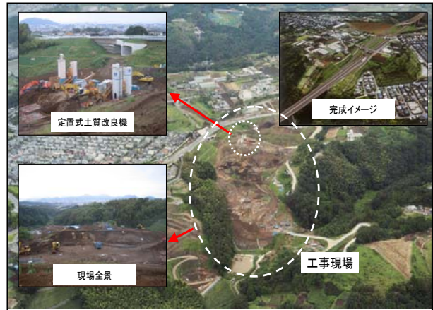
図 5-5 伊豆縦貫道-塚原 IC 工事の様子
