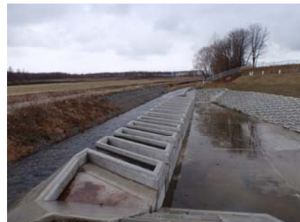
写真-1 排水路分流施設
