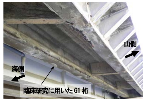
写真-3.2.1 撤去前の状況 （手前：対象橋梁，奥：本線）
