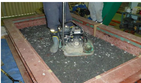
写真-2.3 路盤の締固め状況（プレート）
