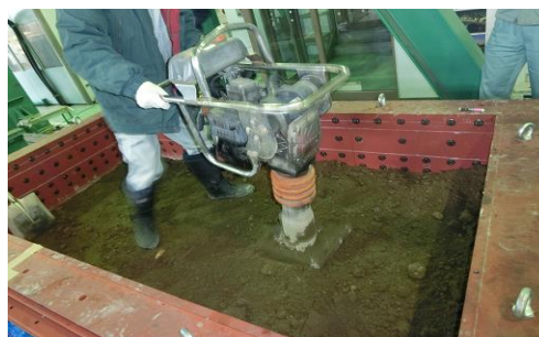
写真-2.1 路床の締固め状況（タンパー）
