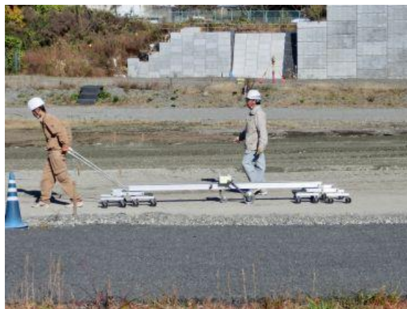
写真-4.2 平坦性測定状況
