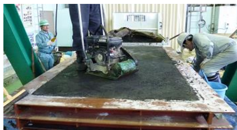
写真-2.4 表層の締固め状況（プレート）
