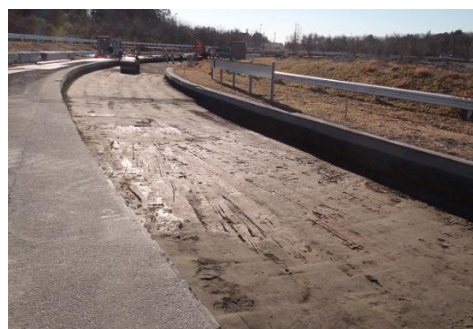
写真-3.1 試験施工箇所(路床施工時)
