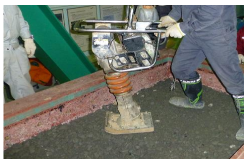
写真-2.2 路盤の締固め状況（タンパー）
