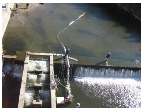
図-53 潜行吸引式排砂管設置状況(11/19)
