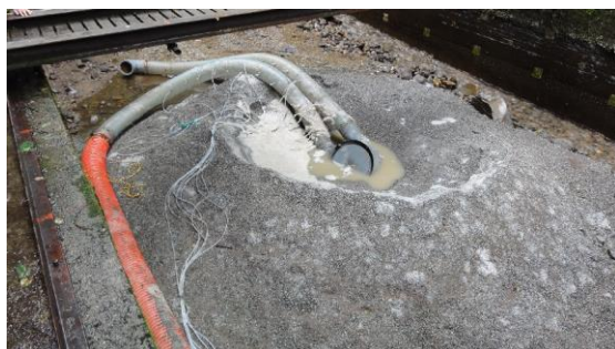
図-35 排砂・排水後の状況 (右岸側下流から、2012年7月)
