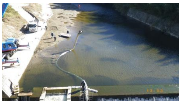
図-52 潜行吸引式排砂管設置状況(11/19)
