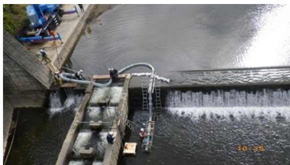
図-51 潜行吸引式排砂管設置状況(11/19)
