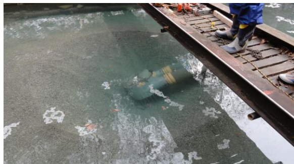
図-47 折返し部の浮き上がり（2012年11月）
