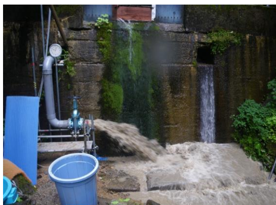
図-34 排砂中の堰堤下流の状況 (2012年7月)
