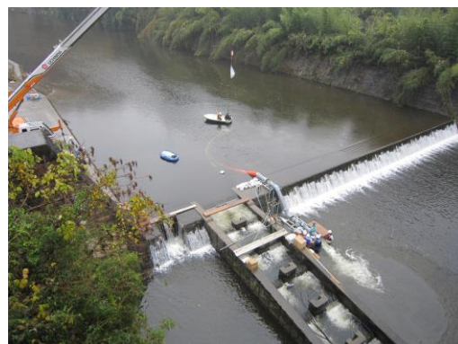
図-105 試験準備中の排砂管の状況
