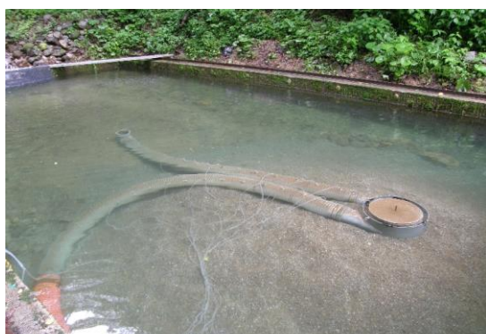
図-33 排砂前の状況 (右岸側下流から、2012年7月)
