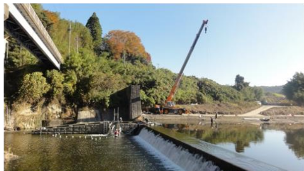
図-54 日竹貯砂ダム(試験時に左岸側から撮影)
