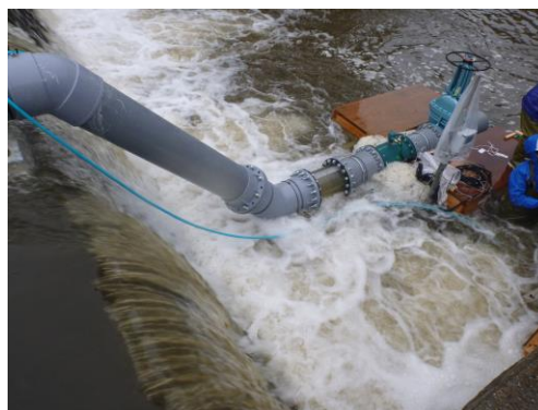
図-103 試験準備途中の出水状況（排砂管下流）
