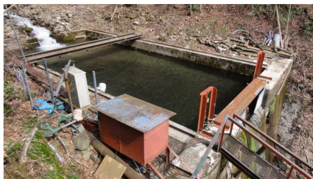
図-27 ヒル谷試験堰堤（右岸側下流上方から撮影）
