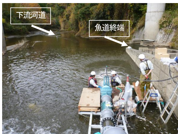
図-109 濁度計設置、計測状況（魚道終端、下流河道）
