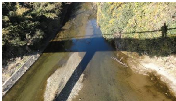
図-81 試験実施中の下流河川の状況 (11/22 9:37)
