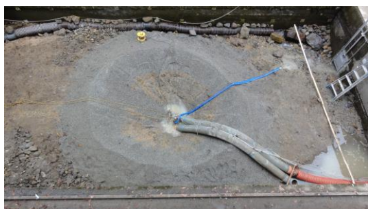
図-37 排砂・排水後の状況（上方から、2012年11月）
