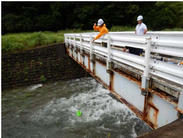
写真-5 荒木川での観測状況
