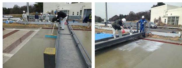
写真 4-2 試験施工状況 (粗面仕上げ)
