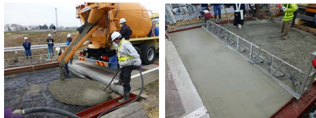
写真 4-1 試験施工状況
