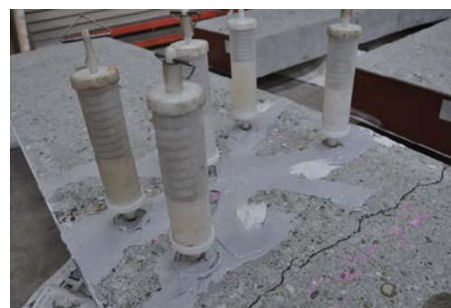
写真-4 ひび割れ注入状況(底面)
