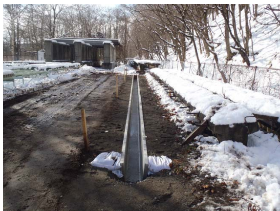
写真-13 U型側溝300B型 設置状況
