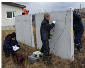
写真-3 超音波伝播速度測定状況
