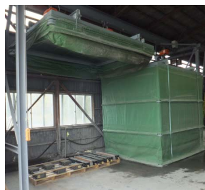
写真-11 蒸気養生室 (右は覆って蒸気養生中、左は蒸気養生開始前)
