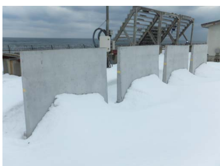
写真-2 L型擁壁設置状況
