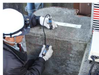
写真-2.1 超音波測定状況
