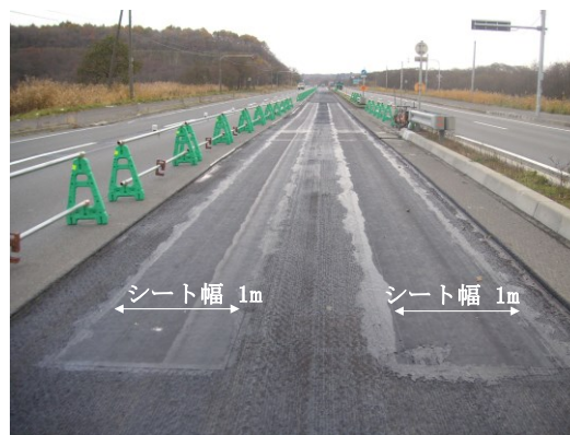
写真4. 2-1 ひび割れ抑制シート貼り付け後の状況
